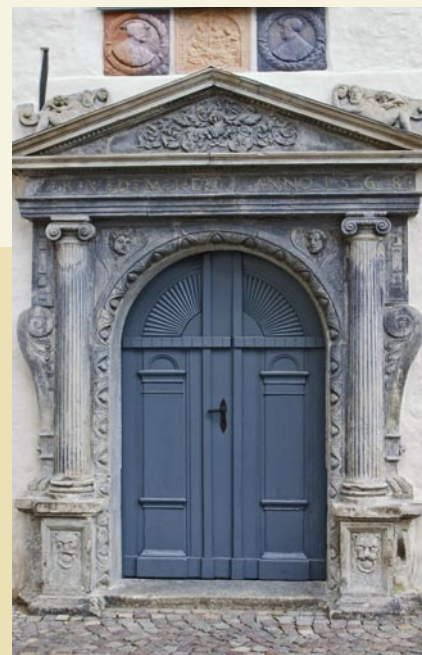
Das Portal vor und nach der Sanierung
